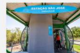
Imagem 23: Estação São José VLT Cariri, METROFOR
