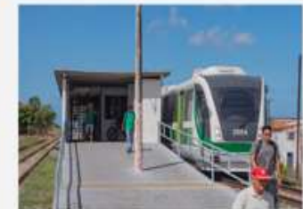
Imagem 11: Estação Papicu, Linha Nordeste METROFOR
