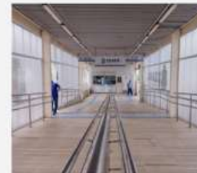
Imagem 08: Estação Iate, Linha Nordeste METROFOR
