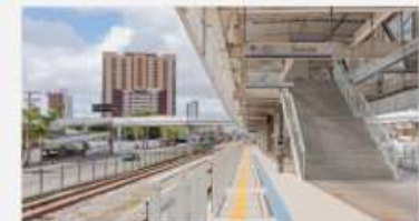
Imagem 11: Estação Papicu, Linha Nordeste METROFOR
