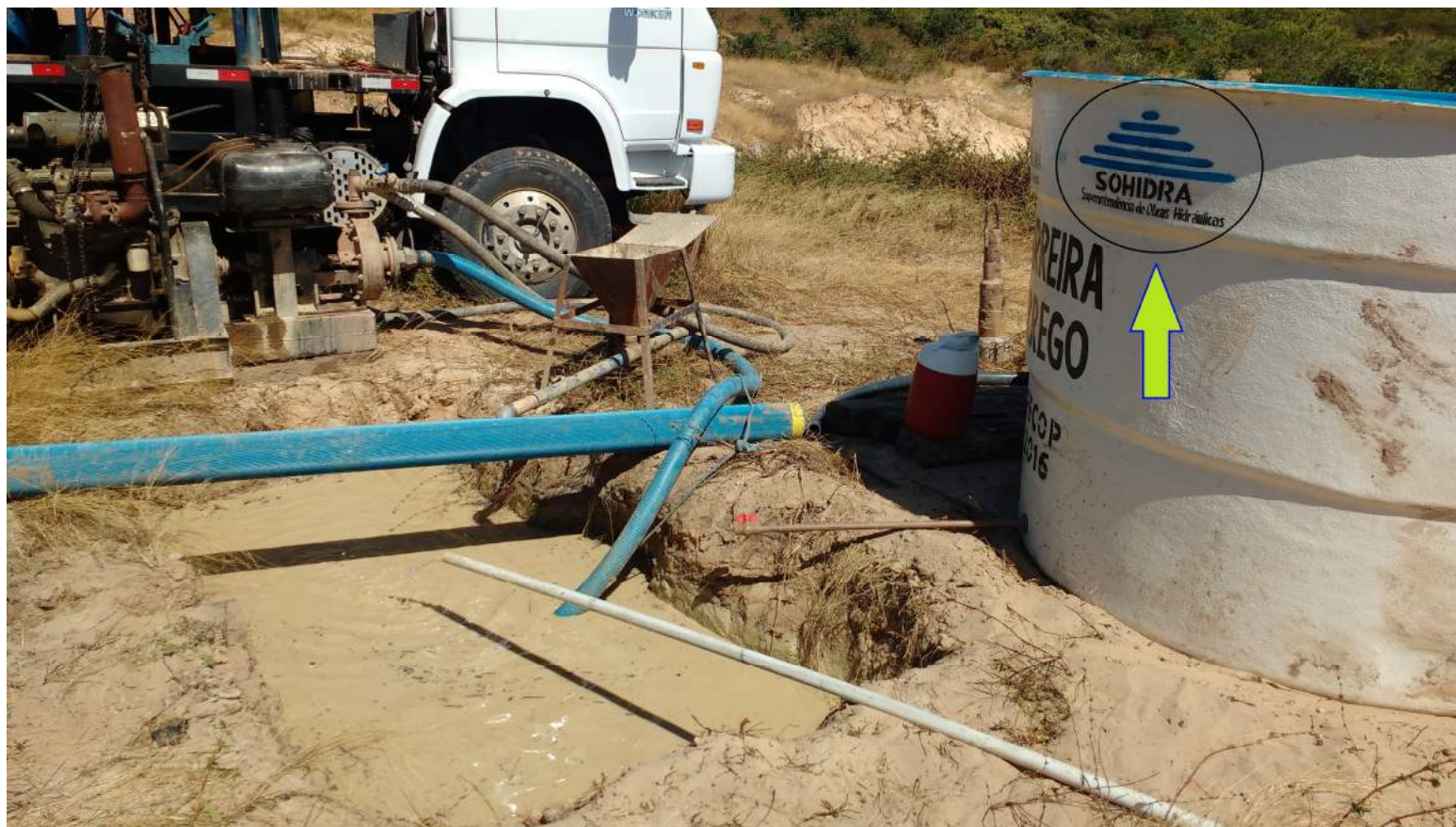
Figura 25 – Detalhe do logotipo da SOHIDRA na caixa d'água utilizada
