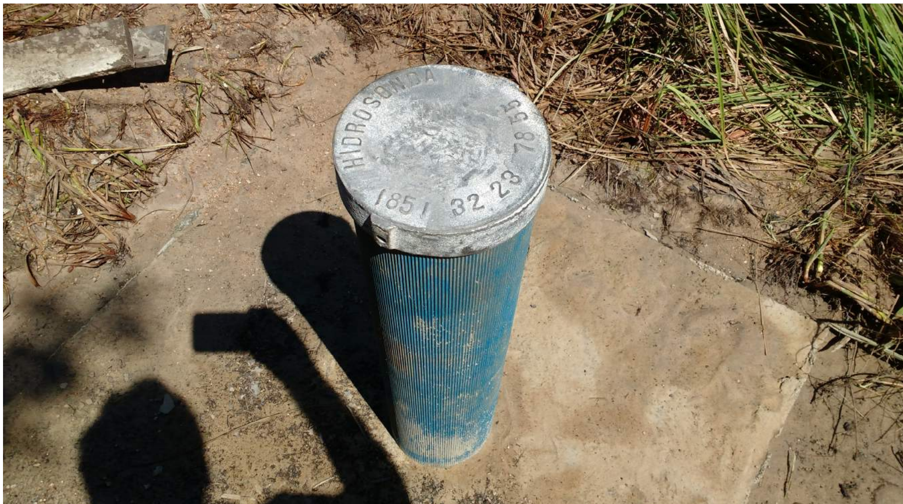
Figura 26 – Tampão do poço contendo a logomarca da empresa Barreto (Hidrosonda)
