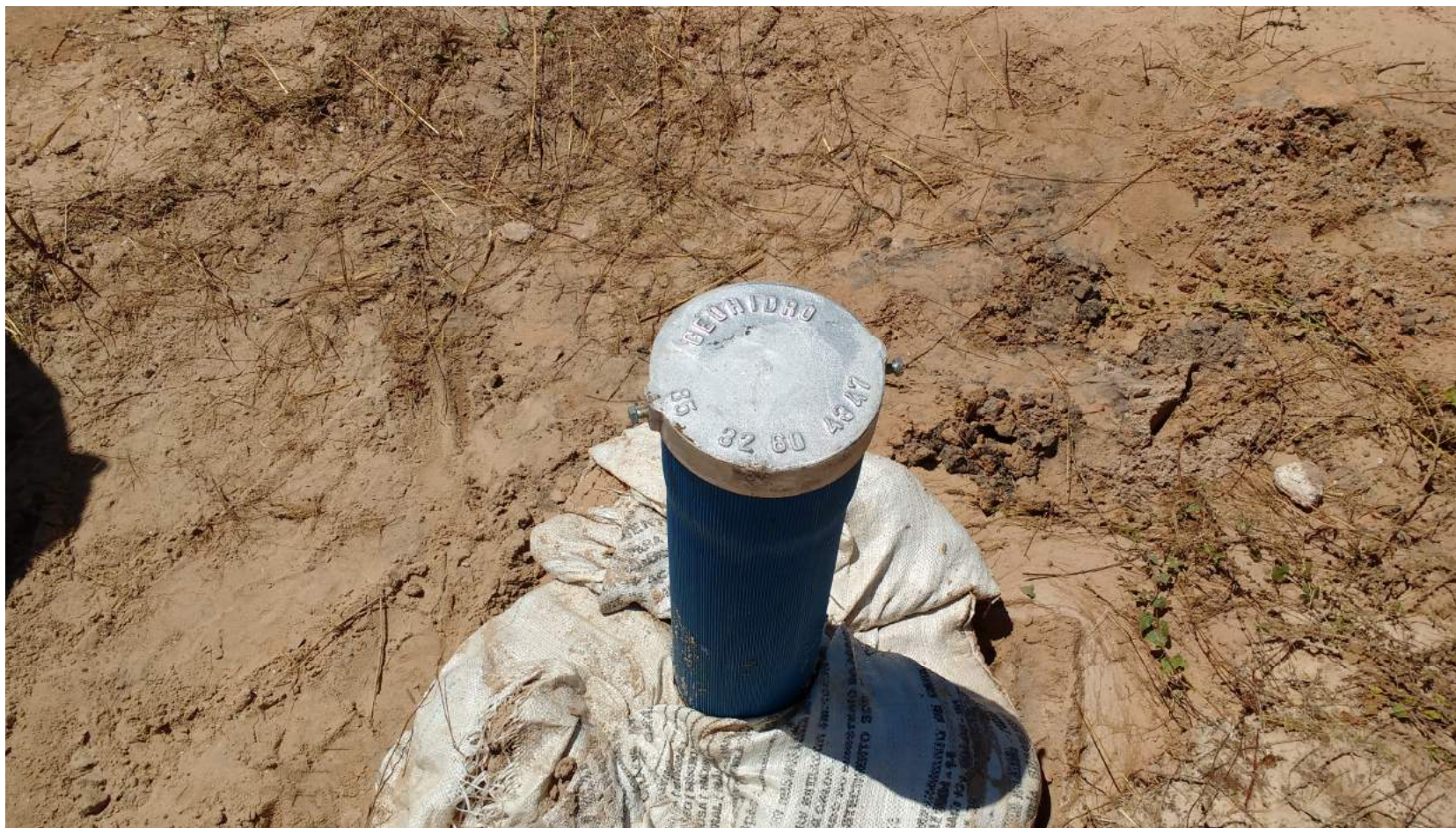
Figura 28 – Tampão do poço contendo a logomarca da empresa Geohidro
