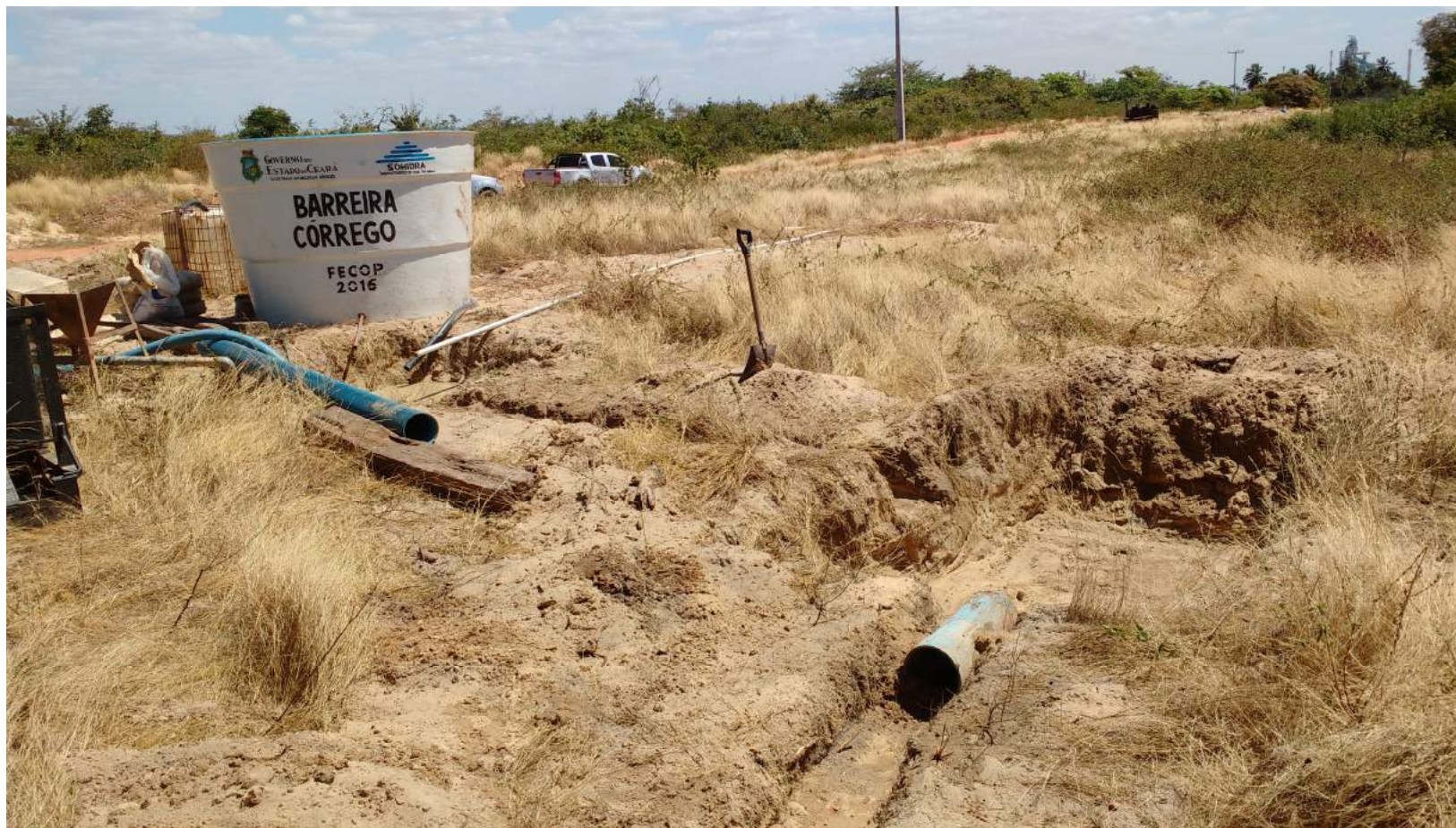
Figura 24 – Utilização de caixa d'água da SOHIDRA no processo de perfuração de poços
