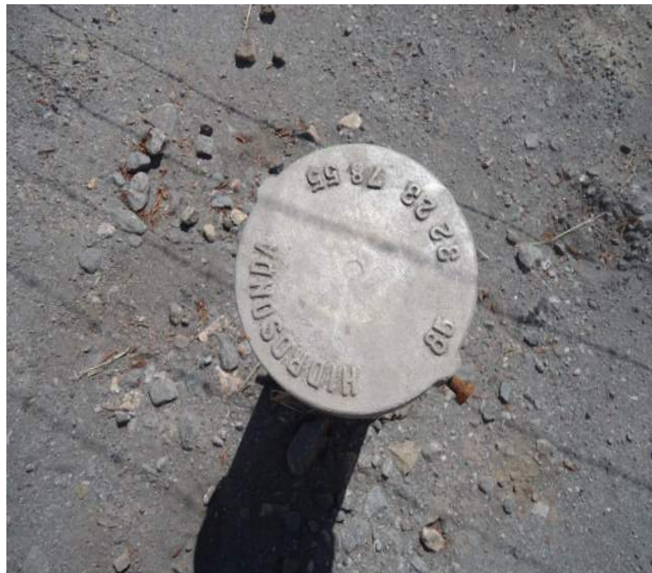
Figura 8 – Detalhe do poço na localidade Córrego do Corcunda OP1 (Morada Nova)
