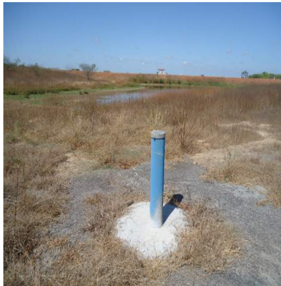
Figura 14 – Detalhe do poço localizado em Cipó dos Anjos (Quixadá)
