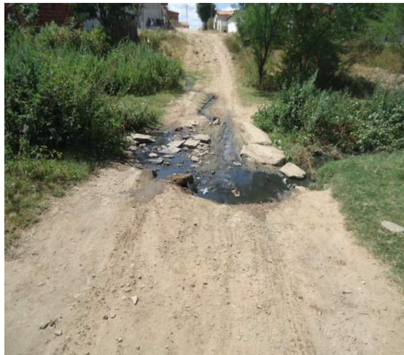
Figura 18 - Poço não encontrado na localidade Lagoa do Mato/Beira Rio (Itatira)
