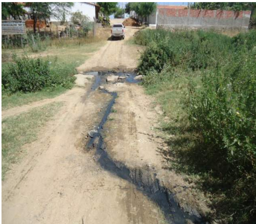
Figura 17 – Poço não encontrado na localidade Lagoa do Mato/Beira Rio (Itatira)
